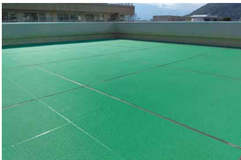
屋上防水工事後
